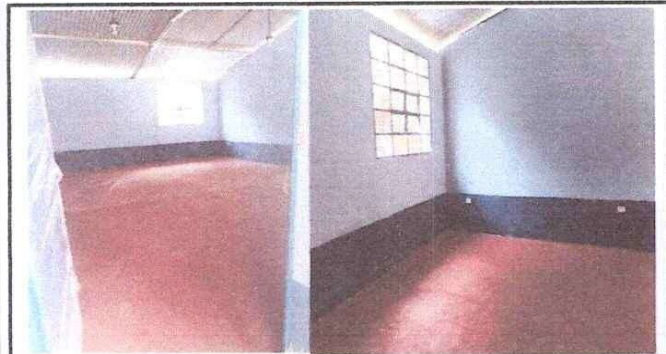
Foto 3: Aplicación de piso entortado, allsado y con color
