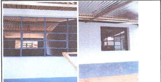
Foto 2: Colocación de cuatro ventanales de metal con vidrio
