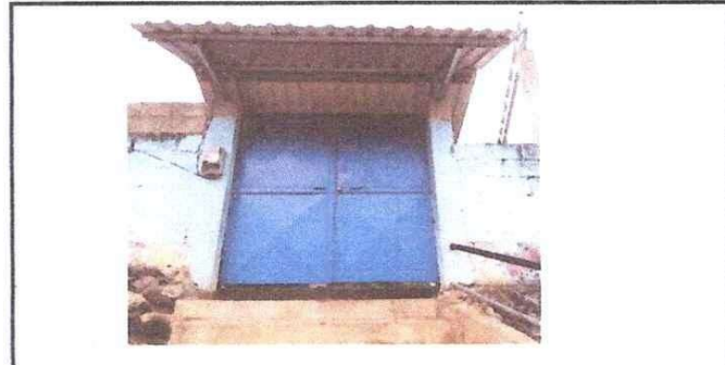
Foto 6: Mantenimiento de portón de metal del acceso al establecimiento y cambio de vigas de madera del techo a estructura metálica.
