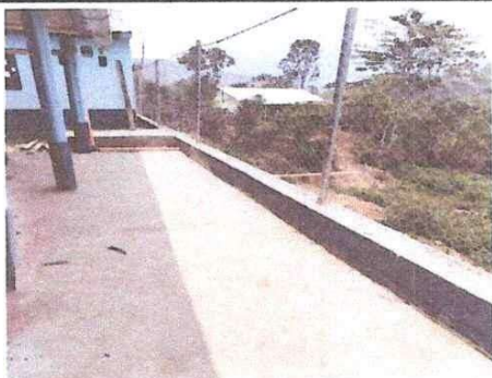
Foto 7: Sustitución de muro perimetral e instalación de malla eléctrica
