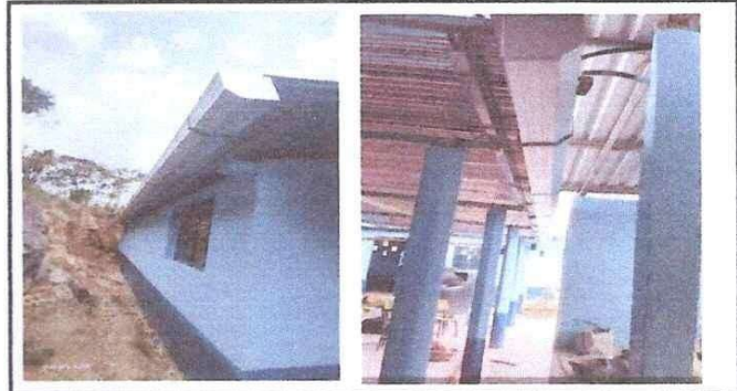
Foto 4: Colocación de canales de agua pluvial para dos aulas
