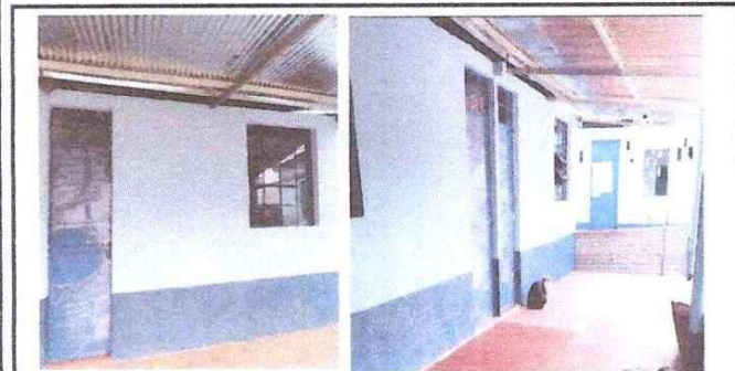
Foto 5: Aplicación de pintura en muros interior y exterior de dos aulas
