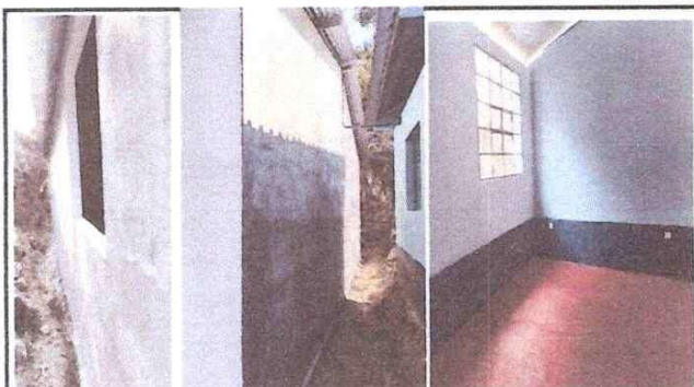
Foto 9: Reparación de repello y cernido
