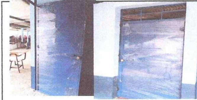
Foto 1: Colocación de dos puertas de metal
